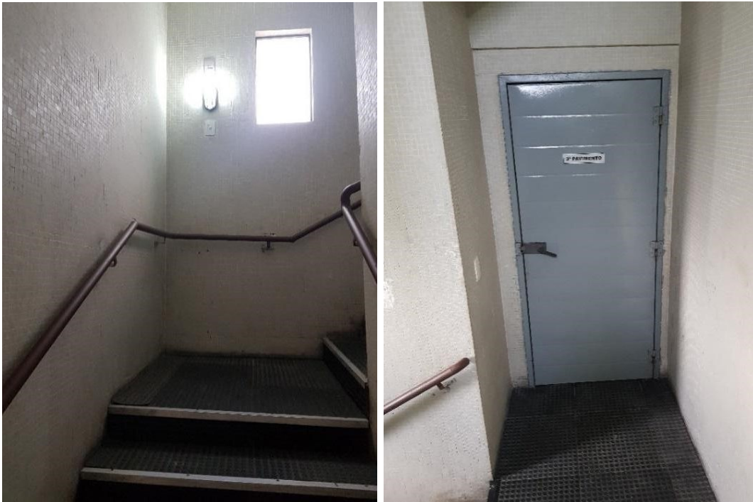
Figura 14 - Interior da escada e porta corta-fogo.
