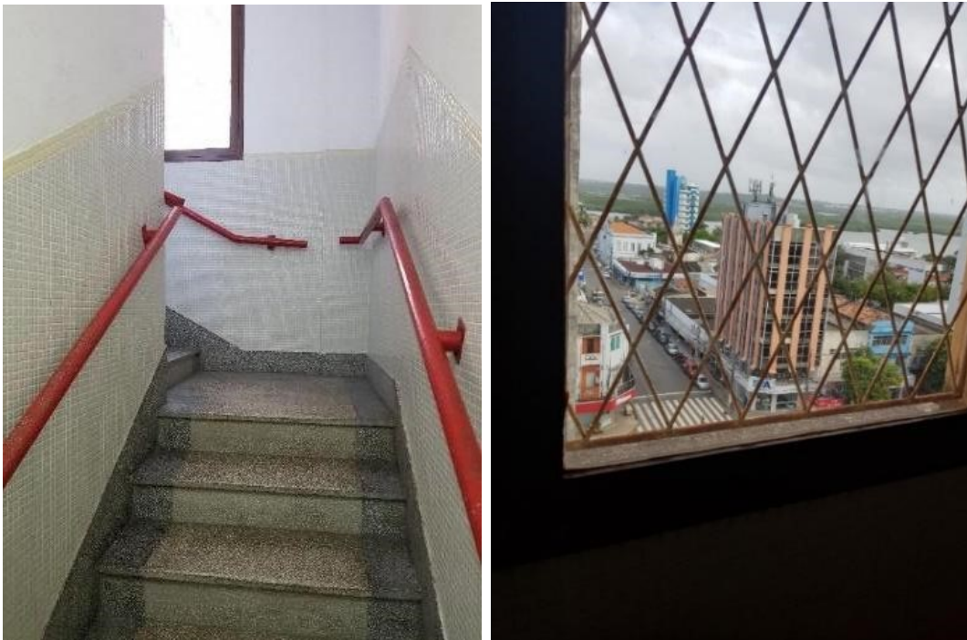
Figura 7 - Lance de escada em que se visualiza a esquadria.
