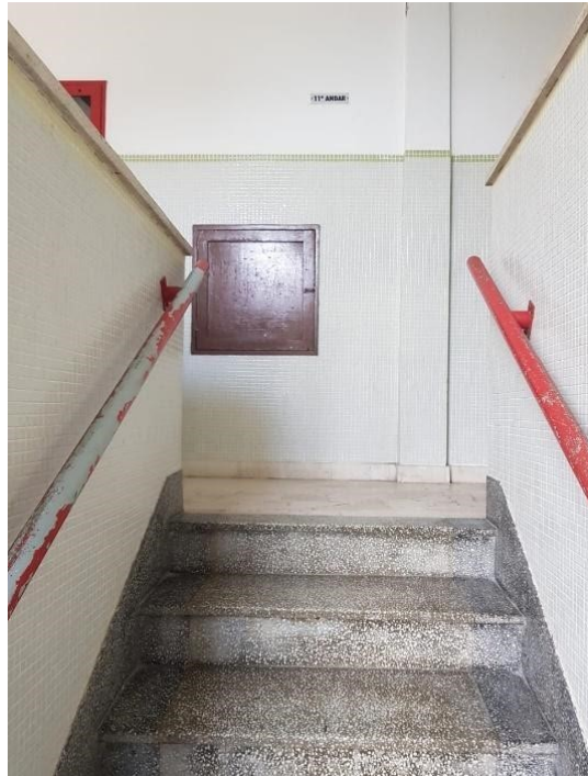
Figura 8 - Término da escada no décimo primeiro pavimento.
