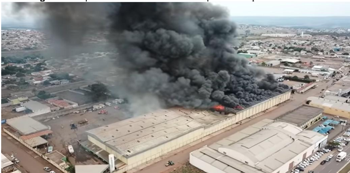
Figura 8 - Aquecimento do teto e não compartimentação da área
