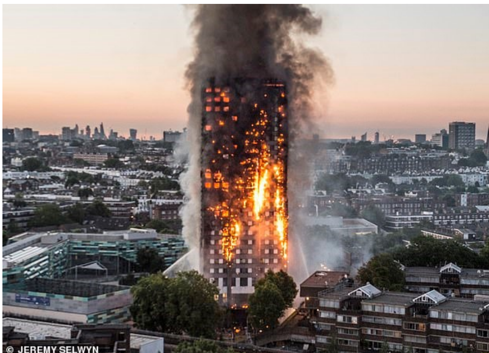
Figura 2 - Imagem do Incêndio no Grenfell Tower
