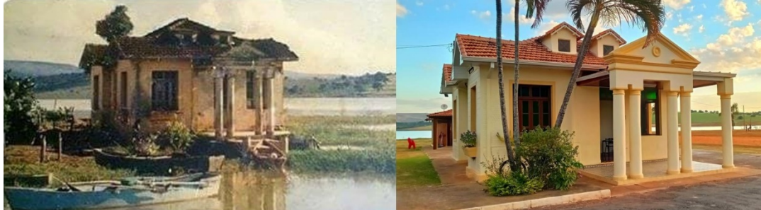
Figura 1 – Casa da Cultura Bangalô (a esquerda, Bangalô em meados dos anos 1970, e a direita no ano de 2022 após obras de restauração).
