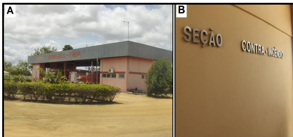
Figura 2 : a) Unidade Corpo de Bombeiros, b) Seção Contra Incêndio.
