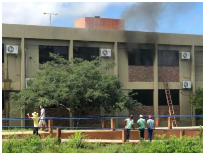
Figura 3. Incêndio na UFCG – foto 1
