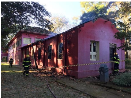
Figura 7. Incêndio na UFMG – foto 1
