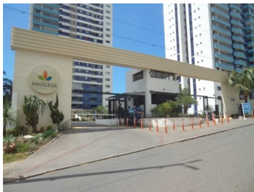
Figura 03 - Acesso à edificação estudada
