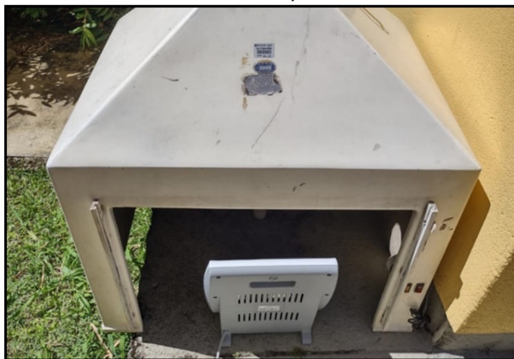
Figura 1 – Aparato experimental montado para o Ensaio 2. No experimento a abertura da capela ficou voltada para a parede, auxiliando o confinamento da atmosfera aquecida.
