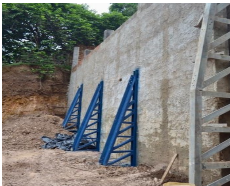
Figura 2 – Muro de contenção da divisa do terreno.
