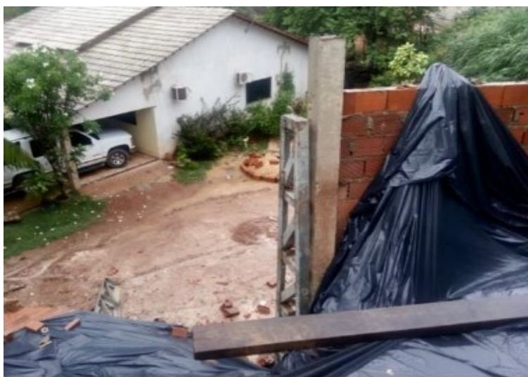
Figura 1 – Residência localizada em nível abaixo do terreno vizinho.
