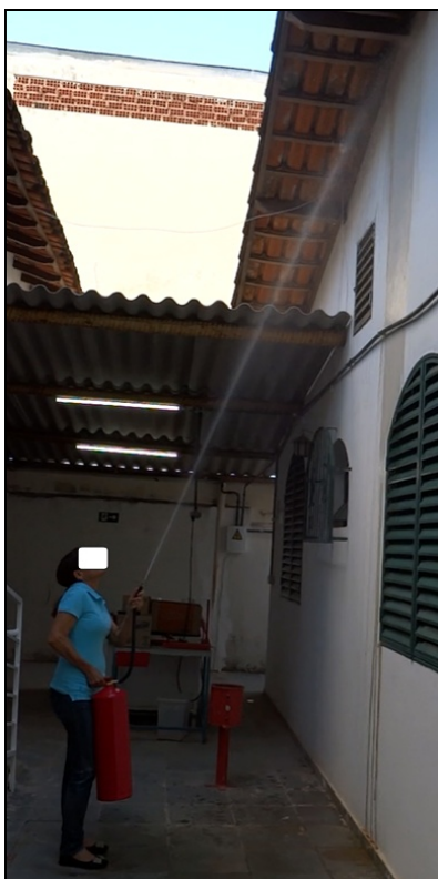
Figura 1 – Disparo do extintor AP com o jato direcionado a um ponto a 5 m de altura.
