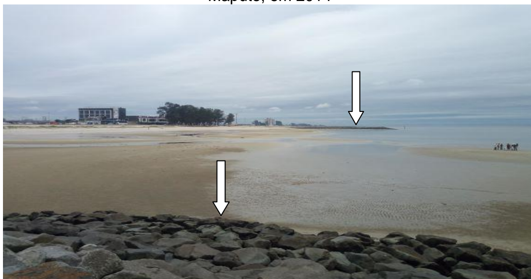
Figura 12 - Esporões, Feitos no Âmbito da Reabilitação da Costeira da Baía de Maputo, em 2014
