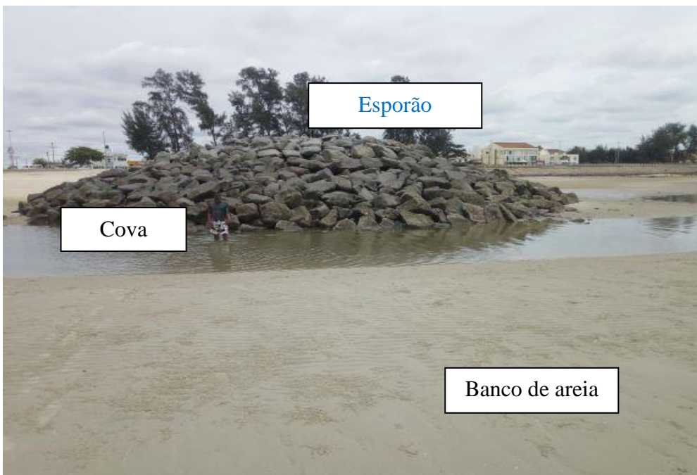
Figura 10 - Bancos de Areia, Esporão e Cova com Profundidade de Cerca de 0,5 Metros, em Período de Baixa Maré
