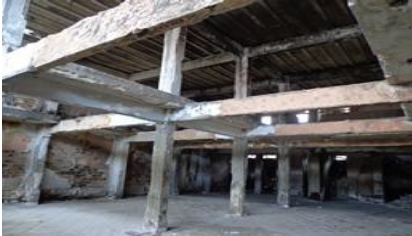
Figura 10 - Viga central danificada armaduras expostas.
