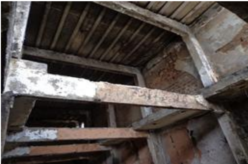
Figura 10 - Viga central danificada armaduras expostas.
