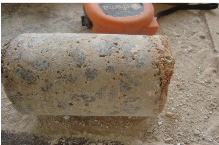
Figura 8- Testemunho de viga com revestimento argamassado pouco afetado pelo fogo.
