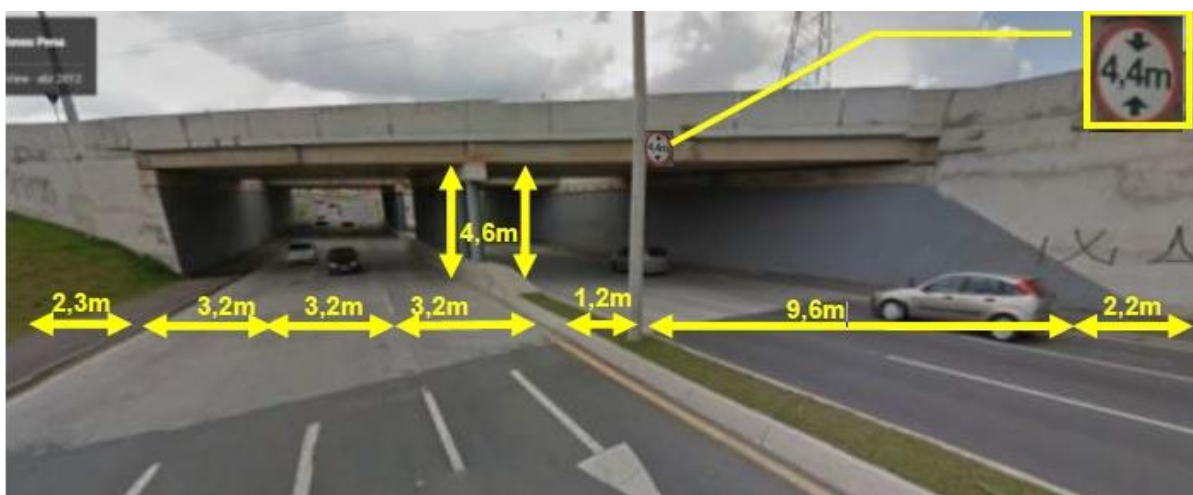
Figura 9 – Município de São José dos Pinhais, trincheira Av. das Torres com Av. Rui Barbosa Fonte: Fernandes (2015)
