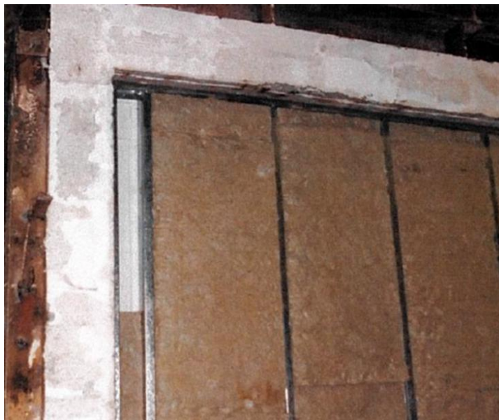
Figura 12: Estrutura e isolamento térmico no corpo de prova
