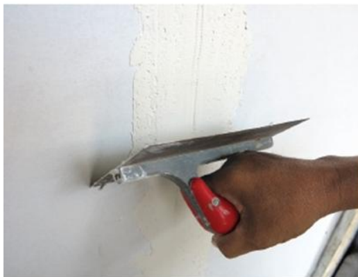
Figura 10: Tratamento entre juntas
